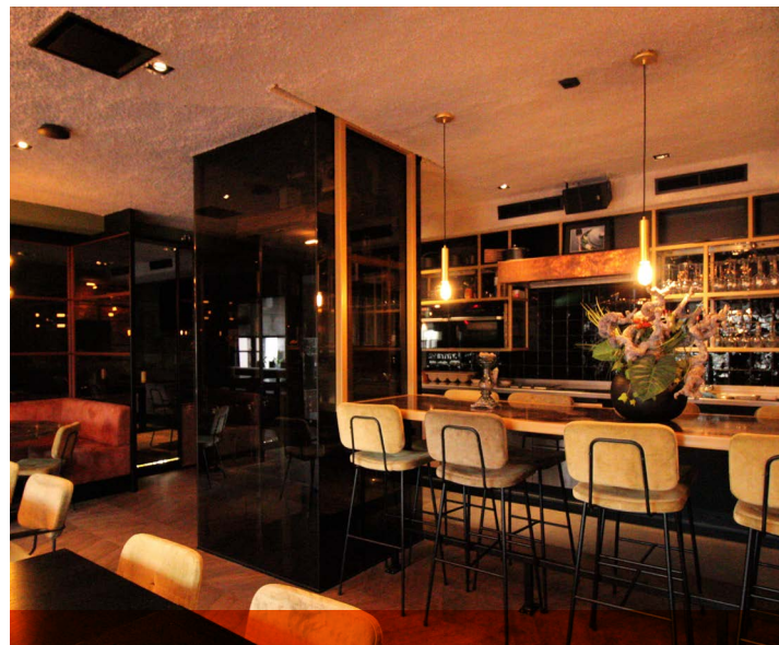
Cabine en schacht voorzien van rookglas panelen
